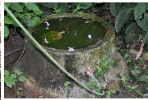
Sur la gauche la rigole amène les excréments de cochon dans le réservoir de gauche. Le réservoir de droite permet d'équilibrer le contenu. Le tuyau vert amène le gaz dans la maison.
