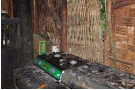
Réchaud à gaz et alimentés par le biogaz
