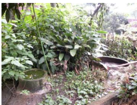
Sur la gauche la rigole amène les excréments de cochon dans le réservoir de gauche. Le réservoir de droite permet d'équilibrer le contenu. Le tuyau vert amène le gaz dans la maison.
