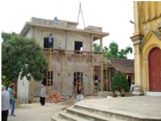
Les travaux avancent : visite du 22 mai 2008
