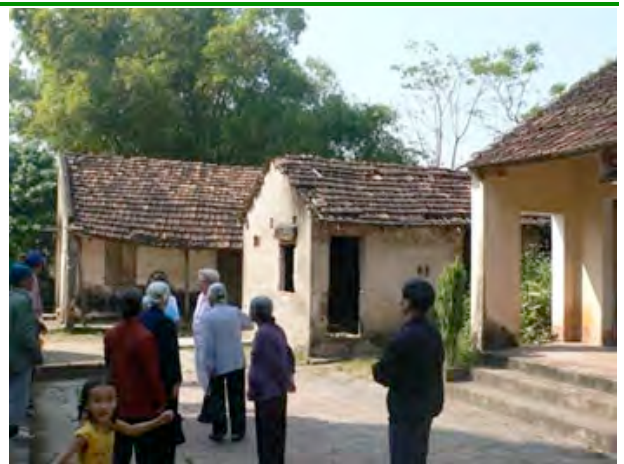
Bâtiments avant rénovation
